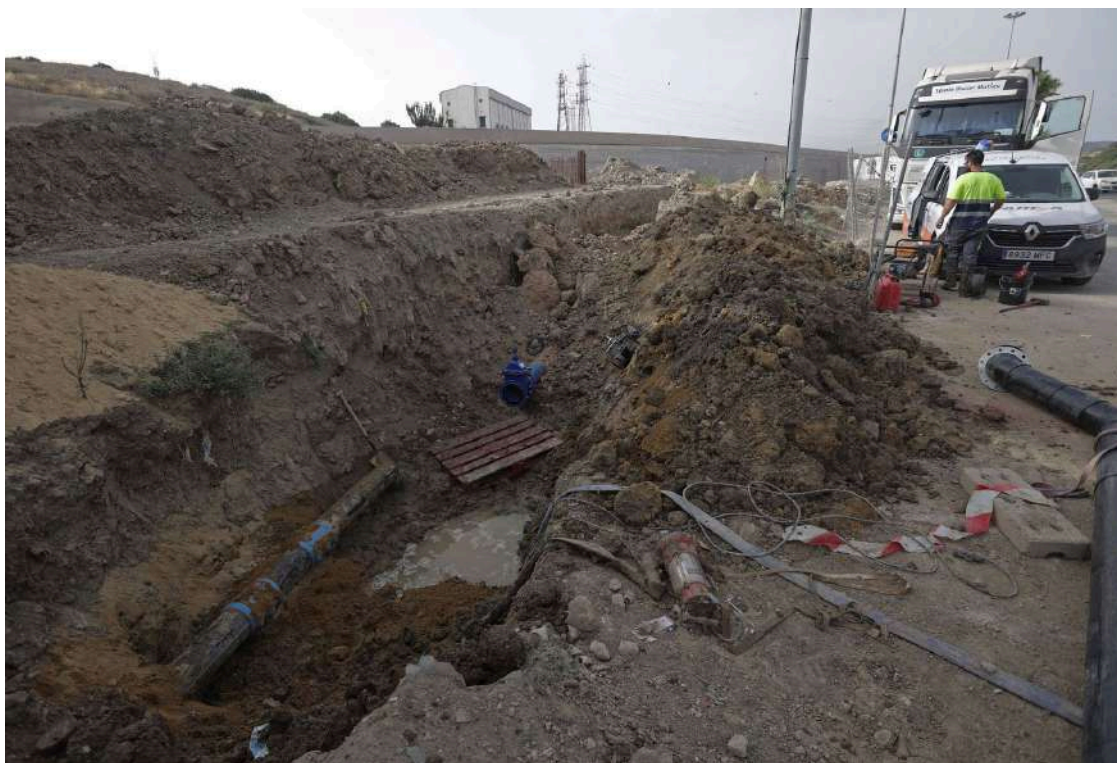
Trabajos de reparación de tuberías en Los Pastores, Algeciras.
