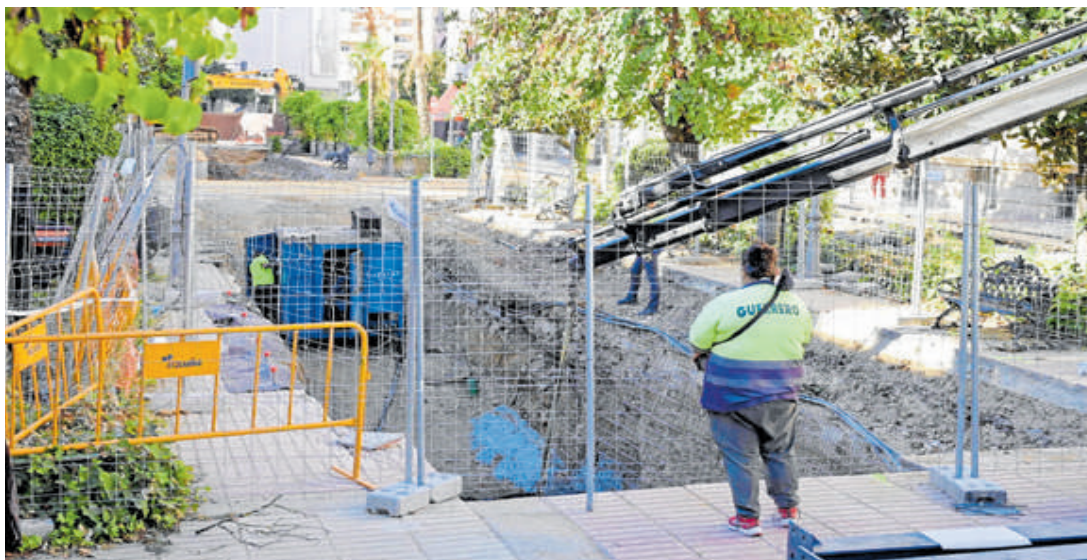
Imagen de las obras del colector de la avenida de Huelva, ayer. J. V. ARNELAS
