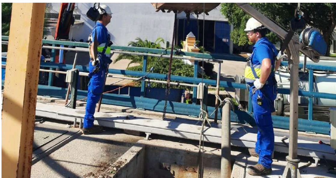
Operarios de APEMSA durante los trabajos de limpieza y retirada de residuos del tanque de regulación de la EDAR Las Galeras, en El Puerto de Santa María.
