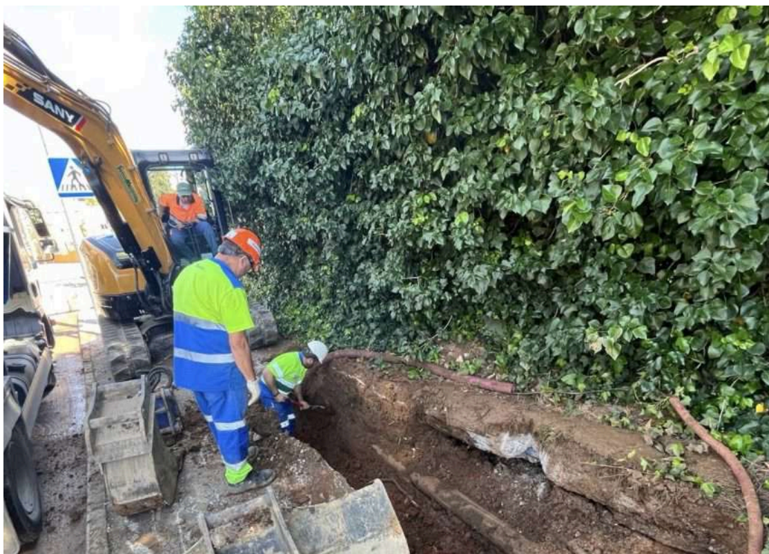
Reparación de Emalgesa en Algeciras / Foto: AAM
