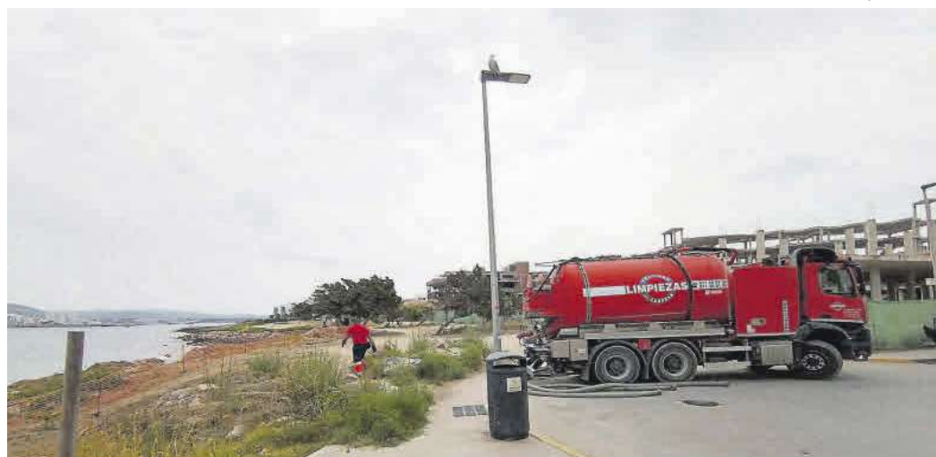
Trabajos de reparación de la red de saneamiento, en julio, tras unos vertidos en Punta Xinxó.
