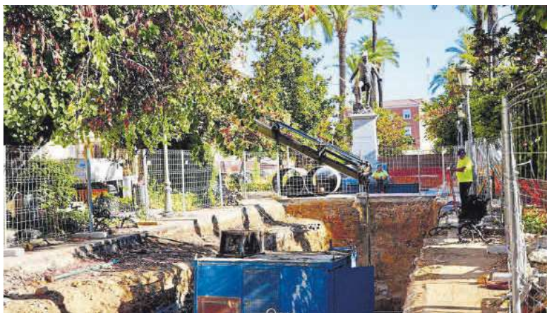
Trabajos para pasar el tubo por debajo de la escultura de Menacho.
